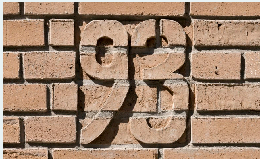
Woning Gouvernestraat (stenen van gerecycled afval)
